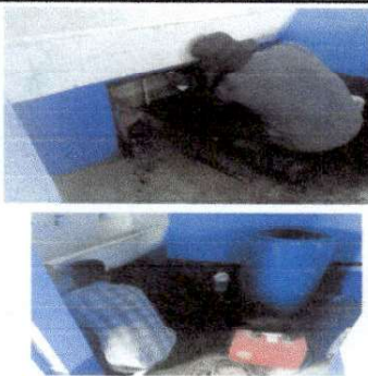
Foto No. 6 Sustitución de puerta de metal para gabinete, sustitución de puerta de metal, sustitución de chapa sobrepuesta Yalle
