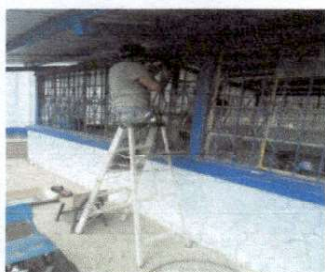
Foto No. 1 Sustitución de vidrios, y mantenimiento de balcones
